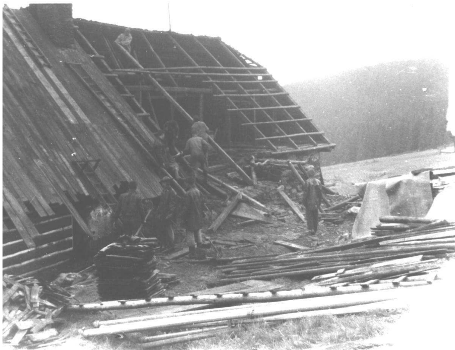
Tak vypadala střecha
